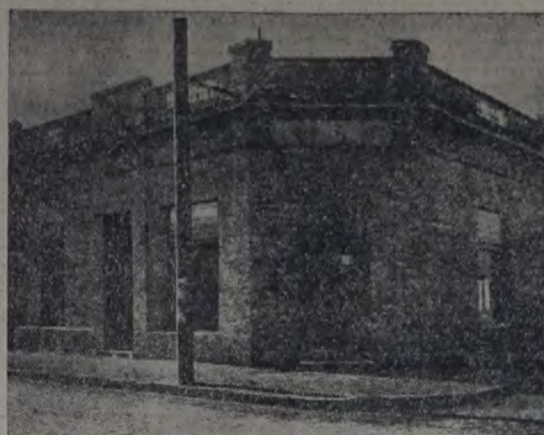
FRENTE DEL EDIFICIO DE LA CASA DEL PUEBLO DE TANDIL, EN LA CALLE ALLEN Y LAS HERAS, DE CUYA RECIENTE INAUGURACION SE OCUPÓ NUESTRO DIARIO
